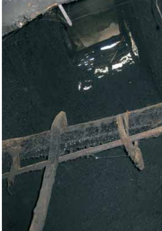
Чађ у оцаку сеоске куће Soot in the peasants' house chimney
